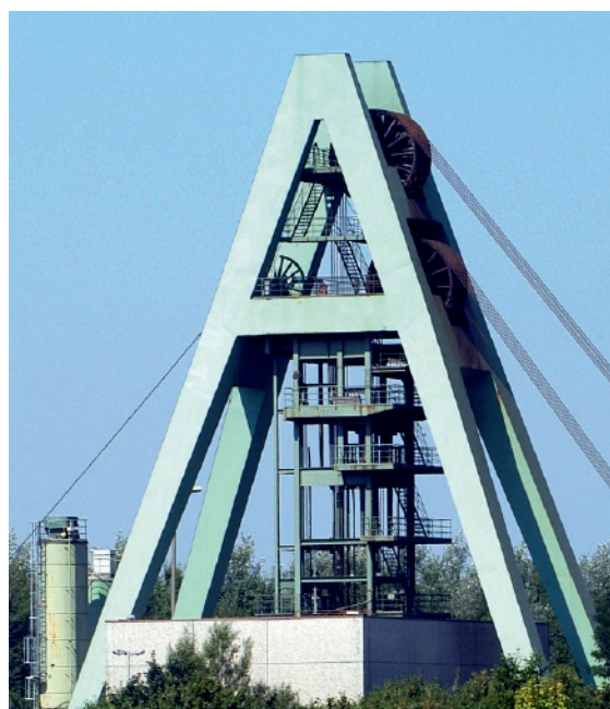
Fig. 3. AV 8 shaft installation. Bild 3. Schachanlage AV 8. Photo/Foto: RAG
