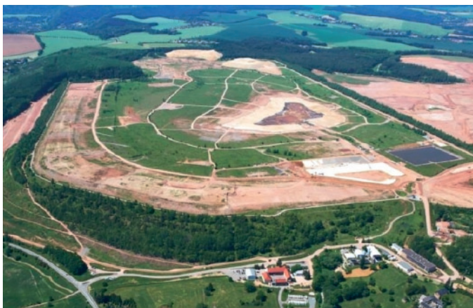
Fig. 3. TMF Culmitzsch and WTP Seelingstädt (in the right foreground). Bild 3. IAA Culmitzsch und WBA Seelingstädt (im Vordergrund rechts). Source/Quelle: Wismut GmbH
