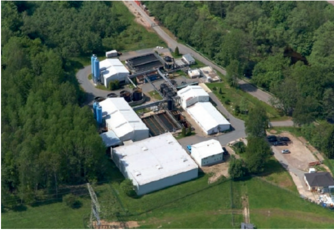
Fig. 1. WTP Schlema-Alberoda. Bild. 1. WBA Schlema-Alberoda. Source/Quelle: Wismut GmbH
