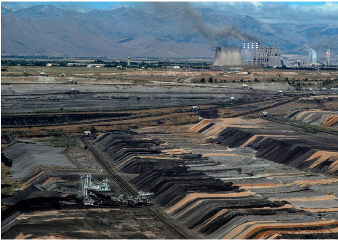
Fig. 6. The Afsin-Elbistan opencast mine. Bild 6. Tagebau Afsin-Elbistan. Photo/Foto: von Hartlieb
