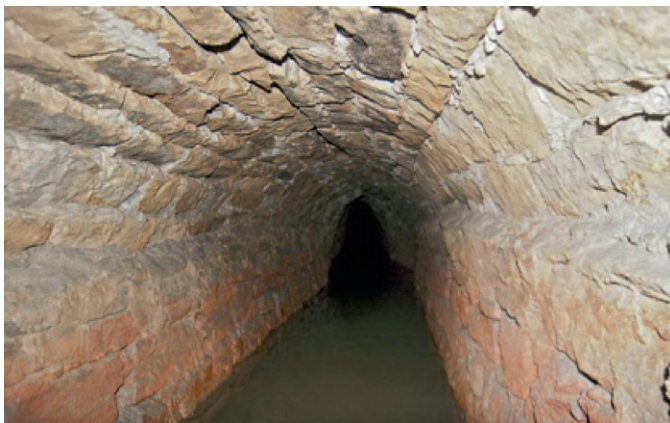
Fig. 2. Drainage adit in sandstone wallin. Bild 2. Wasserlösungsstollen in Sandstein-Mauerung. Photo/Foto: G. Mäscher/M. Sünkler)
