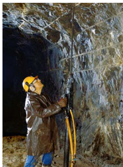
Fig. 4. Stoper rock drill for rockbolting Bild 4. Ankerbohrhammer „Stoper“ Photo / Foto: Atlas Copco
