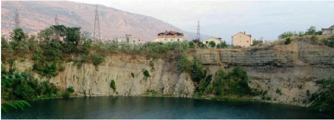
Fig. 9. Southern steep slope area (06/2012). Bild 9. Südlicher Steilwandbereich (06/2012)
