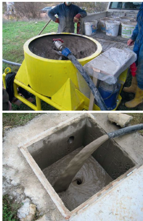
Fig. 4. Blending and injection of slurry (5). Bild 4. Anmischen und Einbringen des „Slurry“ (5).
