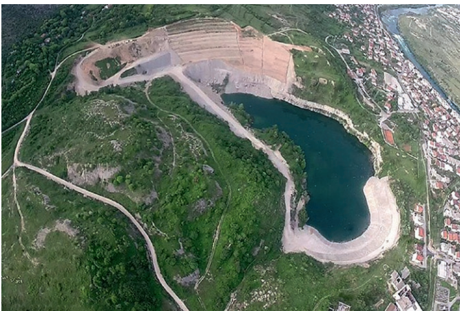
Fig. 11. Aerial view on the remaining pit Vihovići (06/2015). Bild 11. Luftbildaufnahme Tagebaurestloch Vihovići (06/2015).
