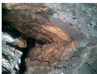
Fig. 4. Tightening the shield column with phenolic resin foam. Bild 4. Abdichten der Schildsäule mit Phenolharz-Hartschaum.
