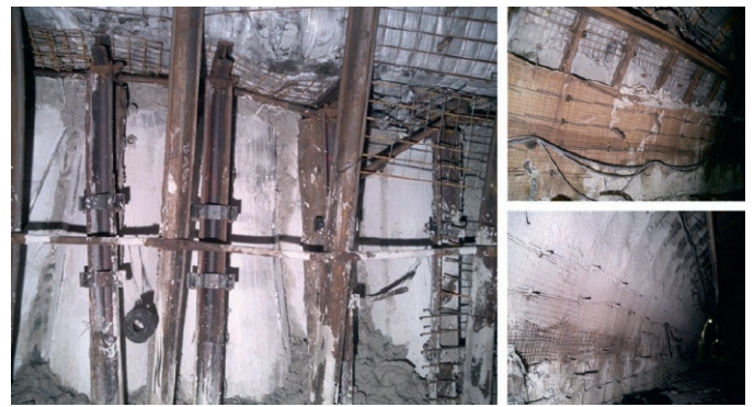
Fig. 3. Tight roadside pack. Bild 3. Dichter Streckenbegleitdamm.
