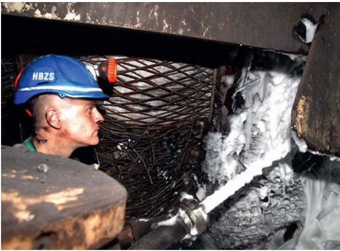
Fig. 8. Treating an area behind the shield support with a handline. Bild 8. Beschäumung hinter dem Schildausbau mit Strahlrohr.
