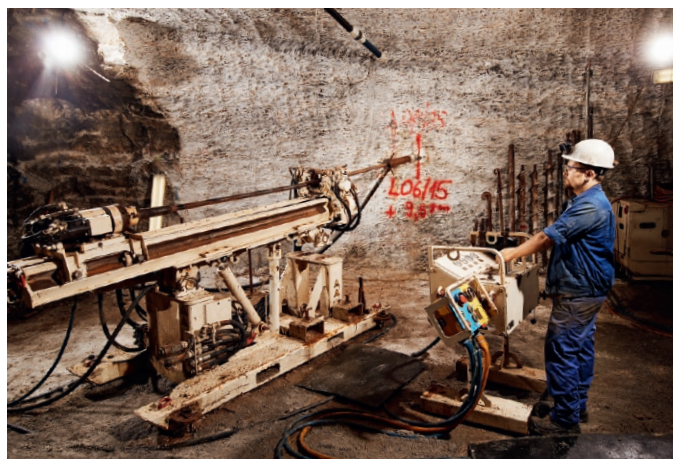
Fig. 5. HLH 120 drill rig. // Bild 5. Bohranlage HLH 120. Source/Quelle: HAZEMAG
