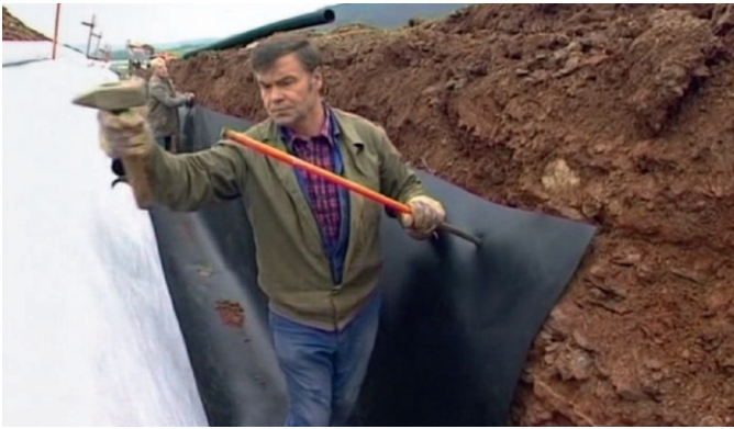
Fig. 22. Construction of catchment channels for dump leach water. Bild 22. Anlegen von Haldenlaugenfassungsräben.
