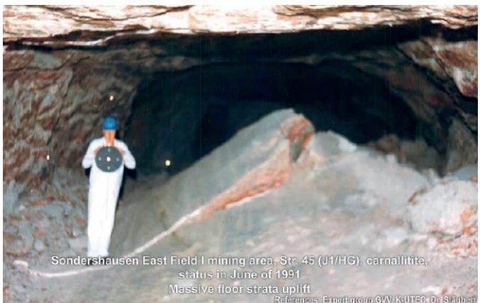
Fig. 6. Massive floor strata uplift (4). Bild 6. Massive Sohlenhebungen (4).
