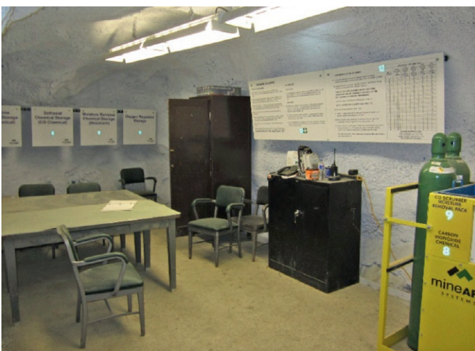
Fig. 3. Inside view of a built-in-place refuge chamber. Bild 3. Innenansicht einer stationären Fluchtkammer. Photo/Foto: Brune
