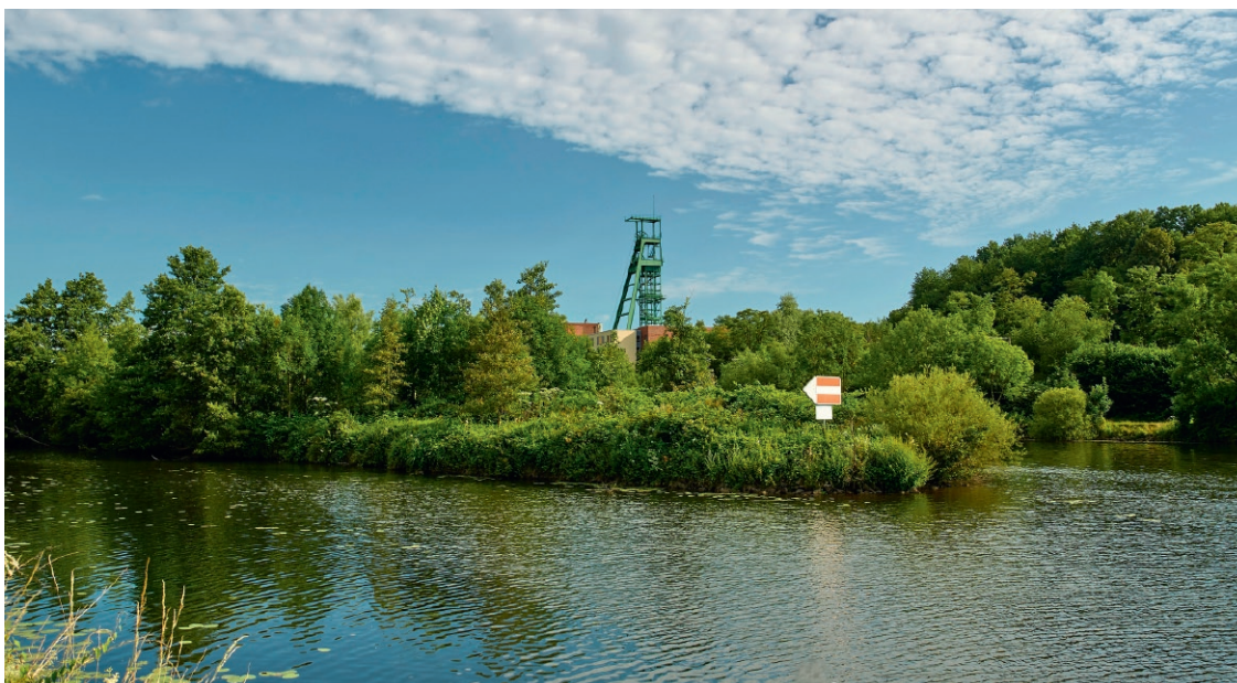
Fig. 1. Looking over the Ruhr valley towards the headgear of the former Heinrich colliery, shaft 3, in Essen that has been used by RAG for pumping out mine water since 1969. // Bild 1. Blick über die Ruhr auf das Fördergerüst des ehemaligen Bergwerks Heinrich, Schacht 3, in Essen. Hier hebt die RAG bereits seit dem Jahr 1969 Grubenwasser. Photo/Foto: RAG
