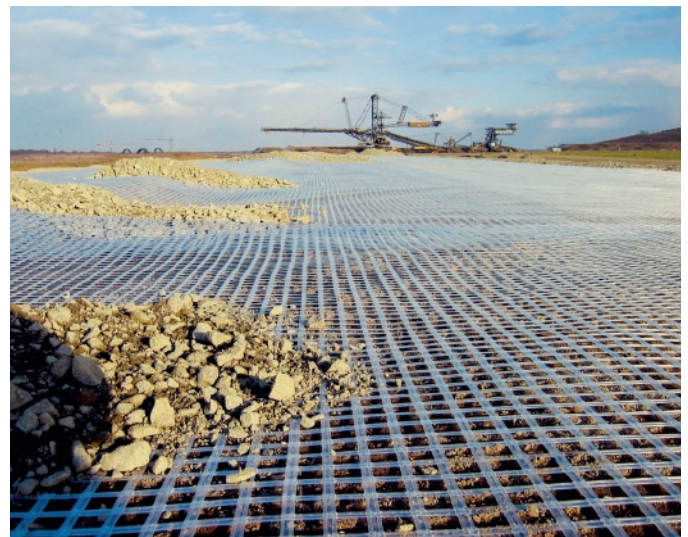
Fig. 5. Application of geogrids in mining operations. Bild 5. Anwendung von Geogittern im Bergbau.
