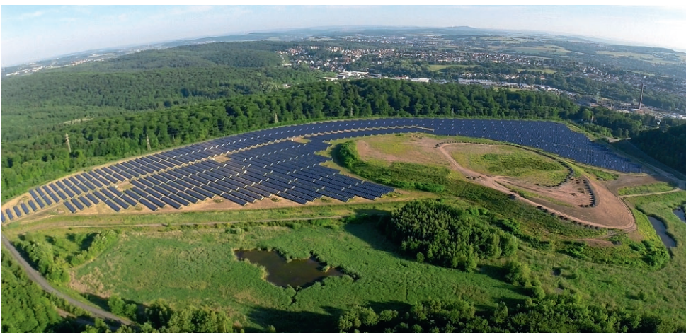
Fig. 5. The new solar energy plant now operating on the 15 ha site of the old Brönnchesthal flotation tailings basin is montanSOLAR's largest individual project to date. Bild 5. Auf dem ehemaligen Absinkweiher Brönnchesthal wurde auf 15 ha Fläche das bisher größte Einzelprojekt der montanSOLAR in Betrieb genommen. Photo/Foto: Becker & Bredel
