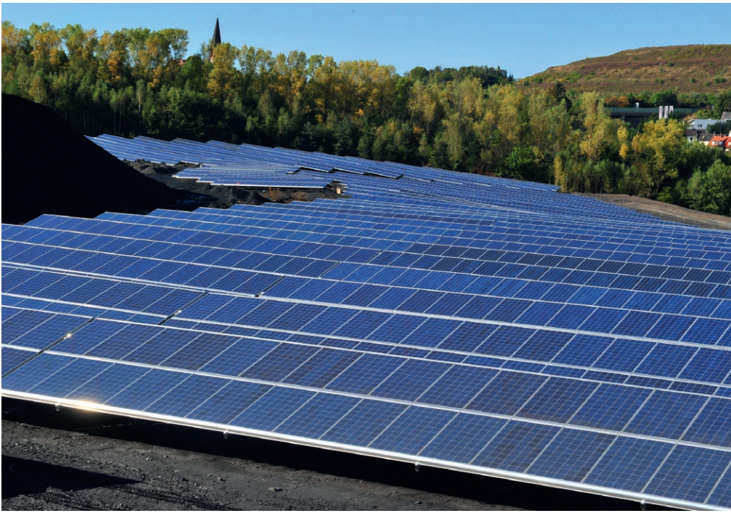
Fig. 4. Mellin is to date the largest solar park that montanSOLAR has established on former RAG land. Bild 4. Mellin ist der bisher größte Solarpark, der von der montanSOLAR auf einer ehemaligen RAG-Fläche realisiert wurde. Photo/Foto: RAG Montan Immobilien
