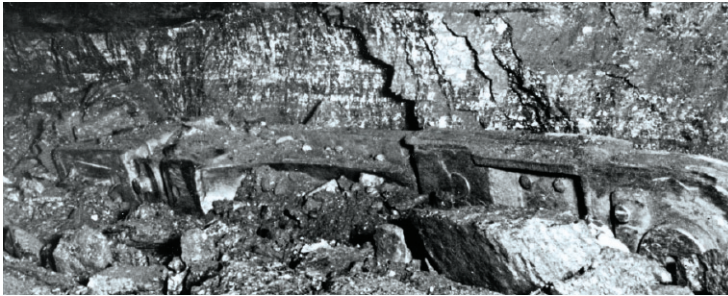
Fig. 5. The Prussian Plow developed by Konrad Grebe. // Bild 5. Preußenhobel, von Konrad Grebe entwickelt.
