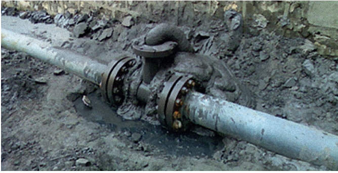
Fig. 14. Concrete-type backfill. Bild 14. Betonartiges Versatzmaterial.
