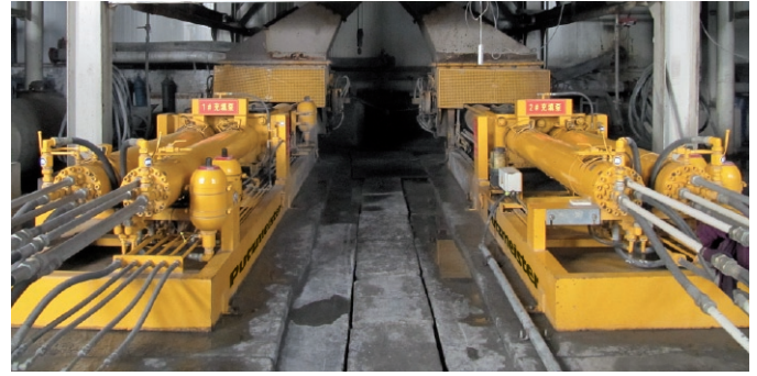
Fig. 15. Two KOS 25100 HP with combined material feed. // Bild 15. Zwei KOS 25100 HP in Redundanz mit gemeinsamem Aufgabetrichter.
