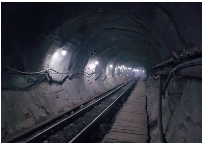
Fig. 14. Completely developed roadway including capital track and water channel (otr, covered) // Bild 14. Fertig ausgebaute Strecke inkl. Hauptfördergleis und Wasserseige. Photo/Foto: SBK
