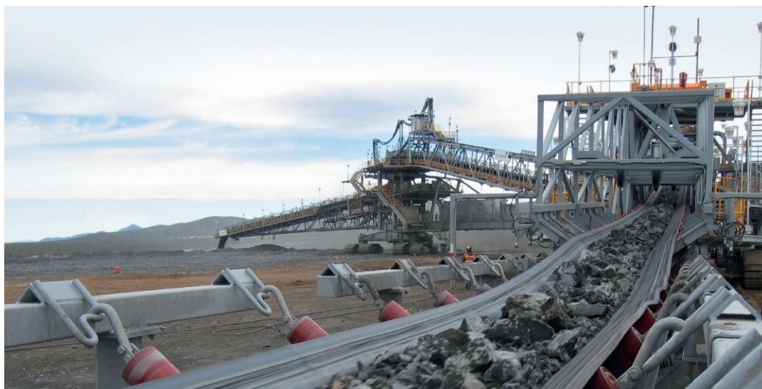
Fig. 1. TAKRAF's material handling system for waste material in Mexico with overland conveyors and stacking equipment. Bild 1. TAKRAF's Abraum-Massengutumschlagssystem in Mexiko mit Förderbandanlagen und Bandabsetzern. Photo/Foto: TAKRAF
