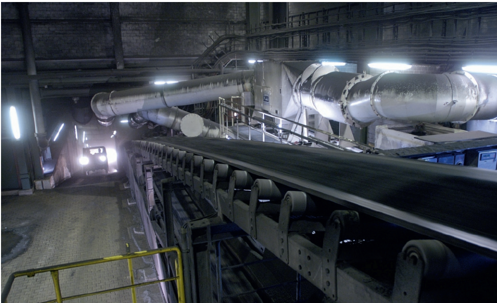
Fig. 2. Surface building for the Prosper-Haniel conveyor drift. Bild 2. Schachthalle des Förderbergs Prosper-Haniel. Photo/Foto: RAG
