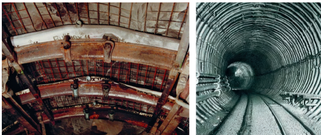
Fig. 9. Yielding arches with segmental backfilling (left) and ring support (right). Bild 9. Gleitbogenausbau mit segmentartiger Hinterfüllung (links) und kreisförmiger Ausbau (rechts).
