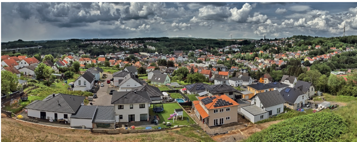
Fig. 4. The "An der Geißwies" residential estate in the Saarland town of Friedrichsthal has given RAG Montan Immobilien an opportunity to showcase its competence as a developer of family housing projects. The site holds 60 individual plots that are to be developed in two phases. Phase one comprises 36 properties, almost all of which have now been placed on the market. // Bild 4. Mit dem Wohnbaugebiet „An der Geißwies“ im saarländischen Friedrichsthal beweist die RAG Montan Immobilien ihre Kompetenz bei der Realisierung von Wohnquartieren für Familien. 60 Wohnbaugrundstücke entstehen dort in zwei Bauabschnitten. Der erste Abschnitt umfasst 36 Grundstücke, die inzwischen nahezu komplett vermarktet sind. Photo/Foto: RAG MI, Thomas Stachelhaus
