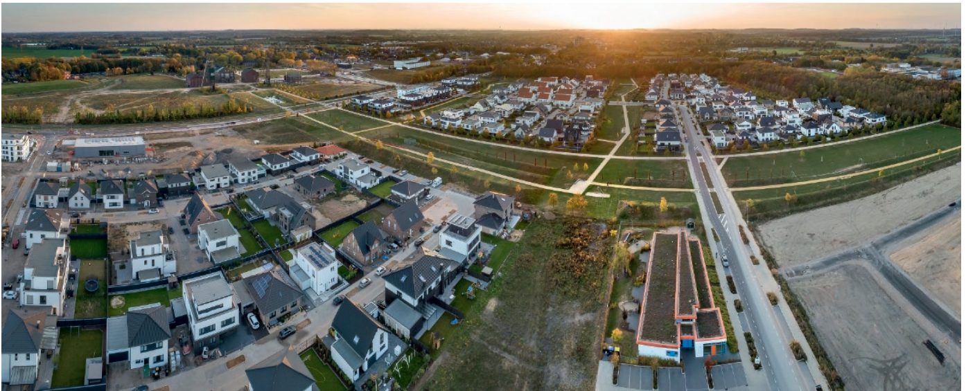
Fig. 1. RAG Montan Immobilien has added another success story by developing the old coal stockyard site of Niederberg 1/2/5 colliery in Neukirchen-Vluyn. The last 64 building plots that form part of four residential zones were sold off in 2018. // Bild 1. Eine echte Erfolgsgeschichte schreibt die RAG Montan Immobilien auf dem ehemaligen Kohlelager des Bergwerks Niederberg 1/2/5 in Neukirchen-Vluyn. Im Jahr 2018 sind hier die letzten 64 Wohnbaugrundstücke von vier Wohnquartieren veräußert worden. Photo/Foto: RAG MI, Thomas Stachelhaus
