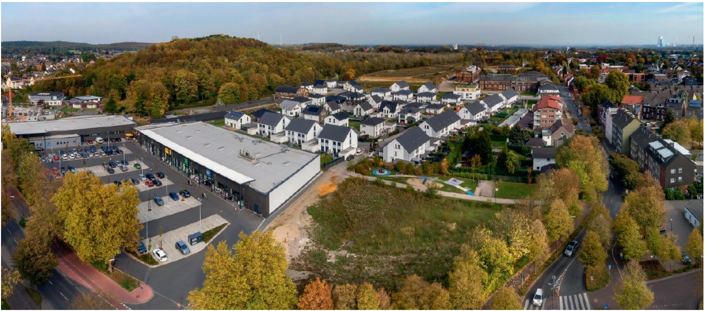
Fig. 3. The Calluna Quarter on the site of the former Ewald-Fortsetzung colliery in Oer-Erkenschwick has housing for families, singles and older residents. The estate lies close to the town centre and now has its own retail zone. // Bild 3. Das Calluna-Quartier auf dem Areal der ehemaligen Zeche Ewald-Fortsetzung in Oer-Erkenschwick bietet Wohnraum für Familien mit Kindern, Singles und ältere Menschen in unmittelbarer Nähe zur Stadtmitte und einem neuen Einzelhandelszentrum. Photo/Foto: RAG MI, Thomas Stachelhaus
