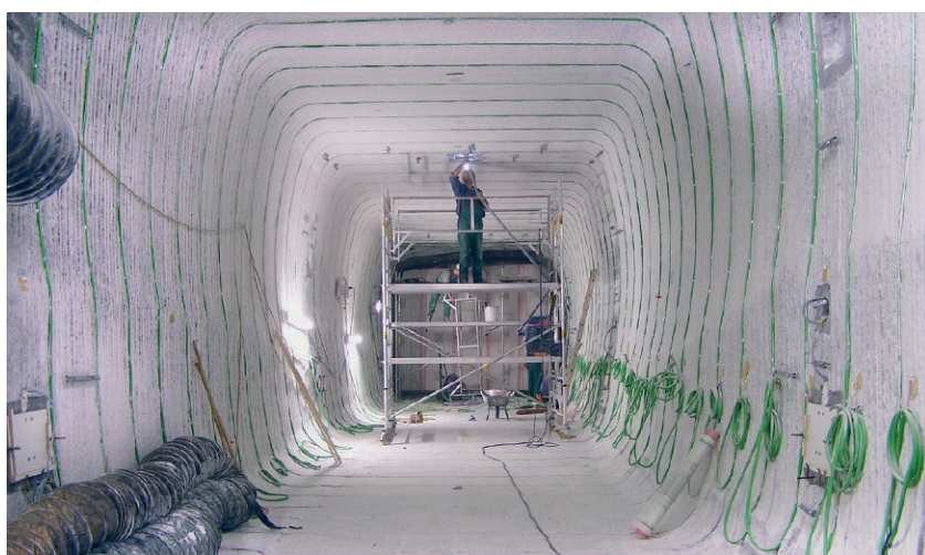
Fig. 5. Installation of measuring and injection technology as part of the construction of a drift seal in rock salt. Bild 5. Einbau der Mess- und Injektionstechnik im Rahmen der Erstellung eines Abdichtbauwerks im Steinsalz. Photo/Foto: BGE mbH
