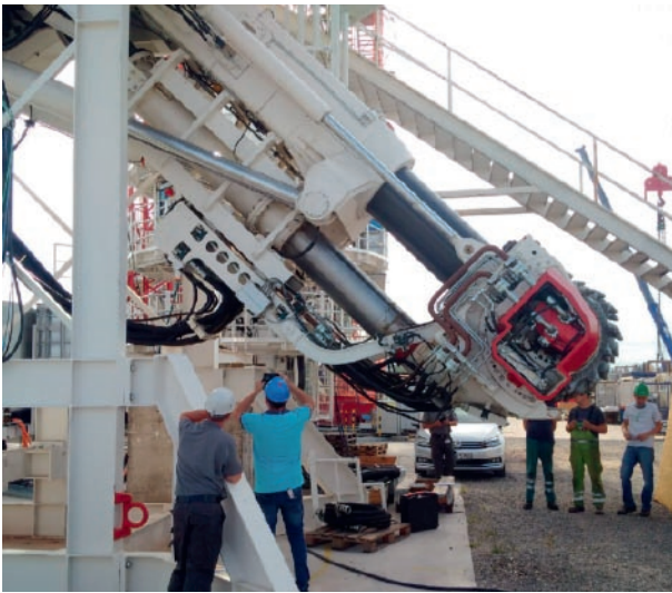
Fig. 5. SBR factory assembly in the summer of 2018. Bild 5. Werksmontage der SBR im Sommer 2018. Photo/Foto: Redpath Deilmann
