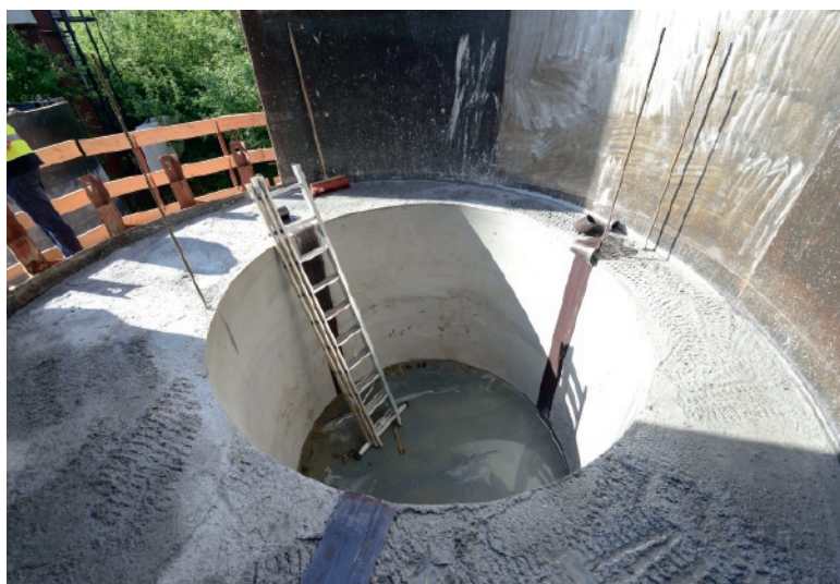
Fig. 11. The first casting section. Bild 11. Erster Betonierabschnitt. Photo/Foto: RAG
