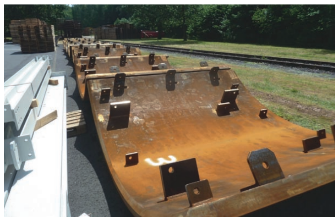
Fig. 11. Sheet metal segments of the steel advancing column with 90° partition. // Bild 11. Blechsegmente der Stahlvorbausäule mit 90°-Teilung. Photo/Foto: Redpath Deilmann
