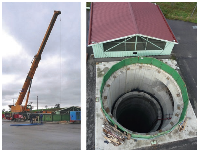
Fig. 1. Shaft hauling by a truck-mounted crane. // Bild 1. Schachttransporte mit dem Autokran. Photos/Fotos: Redpath Deilmann
