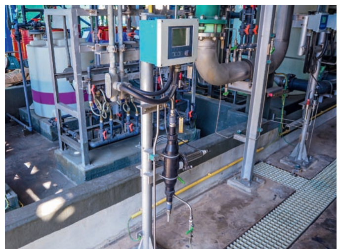
Fig. 2. Analyzer for pH value monitoring. // Bild 2. Messeinrichtung für die pH-Wert-Analyse. Photo/Foto: ©chinnawat – stock.adobe.com
