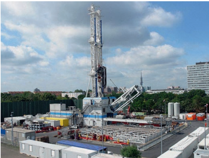
Fig. 3. Drilling rig for the GeneSys research project in Hanover. Bild 3. Bohranlage für das Forschungsprojekt GeneSys in Hannover. Photo/Foto: Anger
