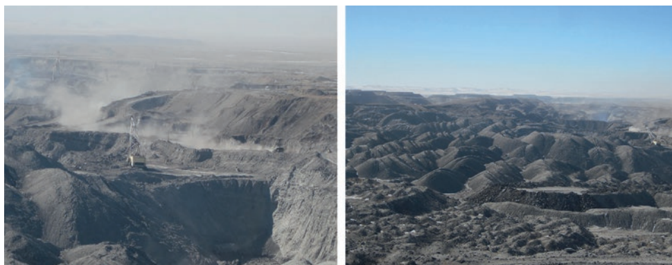
Fig. 4. Lignite surface mine in Baganuur, 140 km east of the capital Ulaanbaatar. Bild 4. Braunkohlentagebau Baganuur 140 km östlich der Hauptstadt Ulaanbaatar. Photos/Fotos: Bauer
