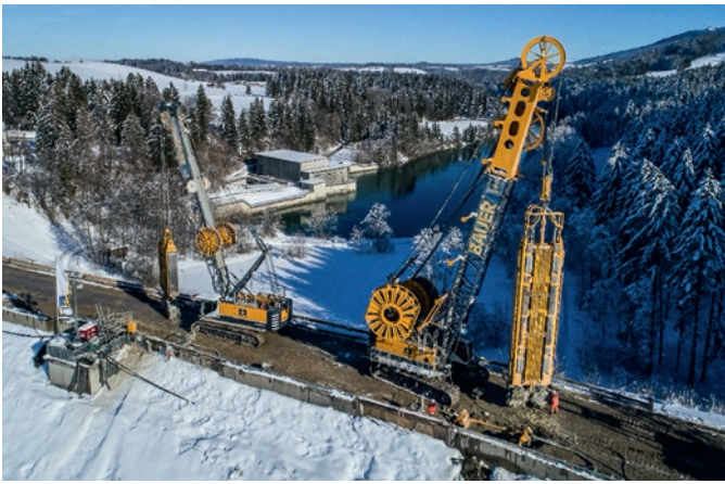
Fig. 4. Trench cutter on a dike rehabilitation project. Bild 4. Schlitzwandfräse bei einer Deichsanierung. Photo/Foto: BAUER
