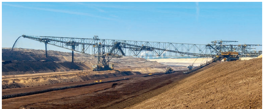
Fig. 7. Overburden conveyor bridge in LEAG's open-pit mine Welzow-Süd. Bild 7. Abraumförderbrücke im Tagebau Welzow-Süd der LEAG. Photo/Foto: LEAG
