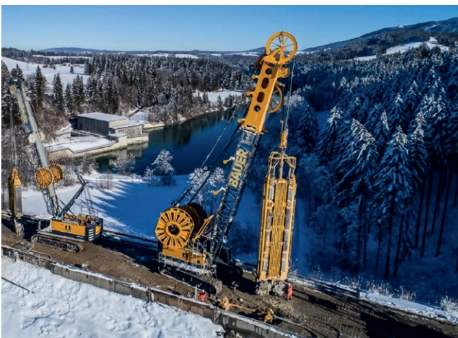
Fig. 2. Standard cutter system for diaphragm walls and cut-off walls – dam project in Germany. // Bild 2. Standard Fräsensystem für Schlitz- und Dichtwände – Staudammprojekt in Deutschland. Photo/Foto: BAUER Spezialtiefbau GmbH
