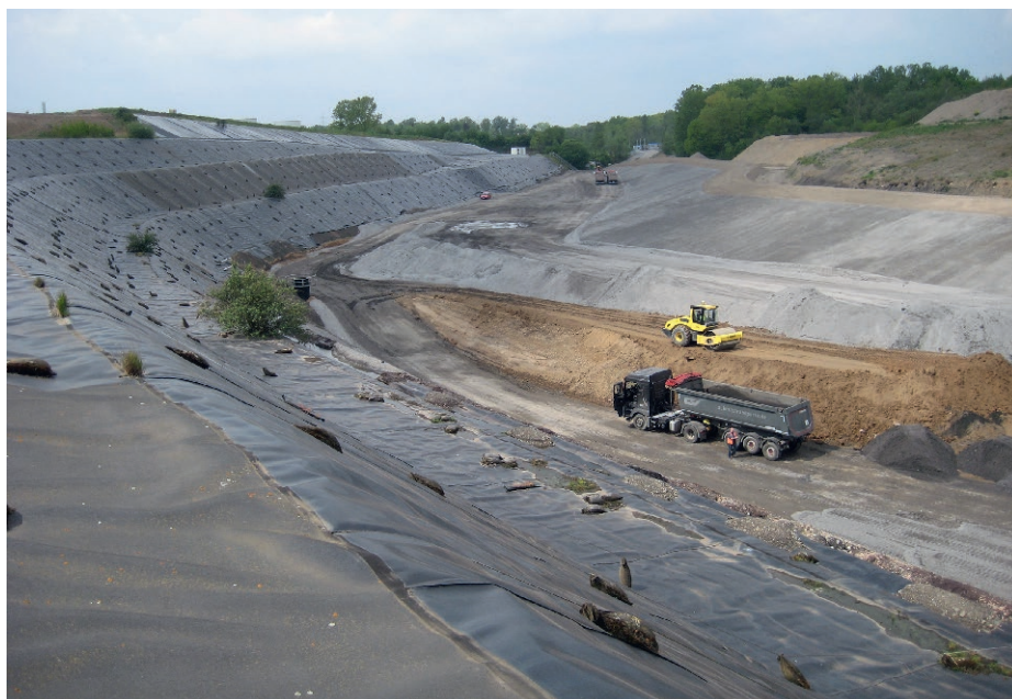
Fig. 3. Waste material being placed at the Vereinigte Ville landfill, clay belt line. Bild 3. Abfalleinbau am Deponiestandort Vereinigte Ville, Tonbandeinschnitt. Photo/Foto: Dr.-Ing. Asenbaum
