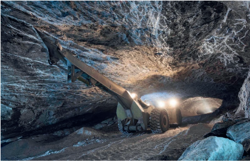
Fig. 4. The scaling machine in action underground. Bild 4. Das Beraubefahrzeug im Einsatz unter Tage. Photo/Foto: GTS
