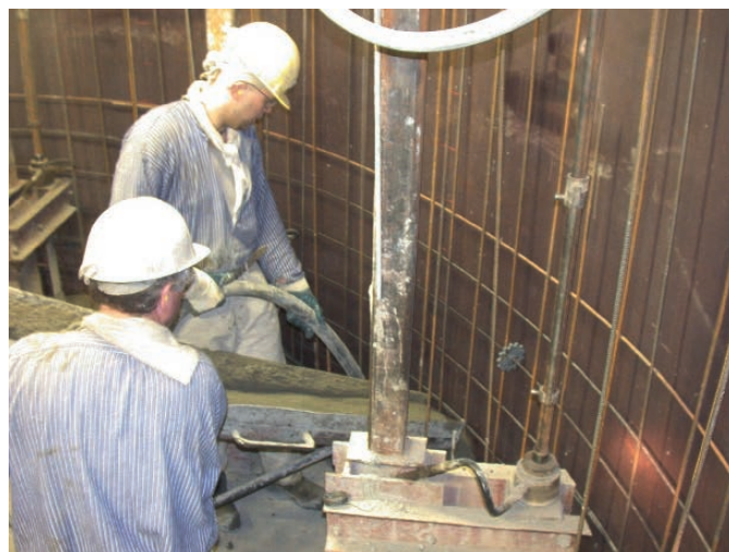
Fig. 1. Working conditions in shaft sinking. // Bild 1. Arbeitsbedingungen im Schachtbau. Source/Quelle: Redpath Deilmann
