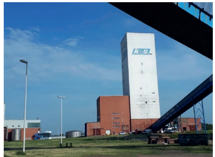
Fig. 10. Zielitz 1 shaft. // Bild 10. Schacht Zielitz 1. Source/Quelle: Redpath Deilmann
