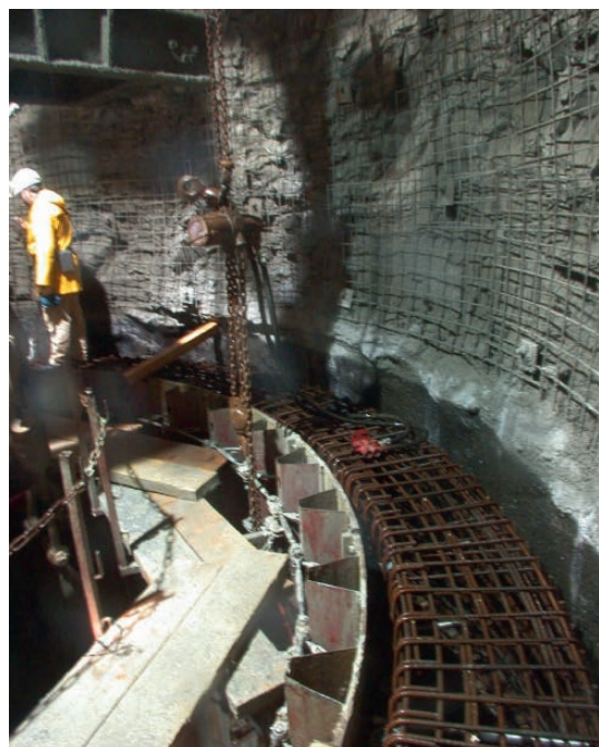
Fig. 2. Placing in-situ concrete in the shaft. // Bild 2. Einbringen von Ortbeton im Schacht. Source/Quelle: Redpath Deilmann
