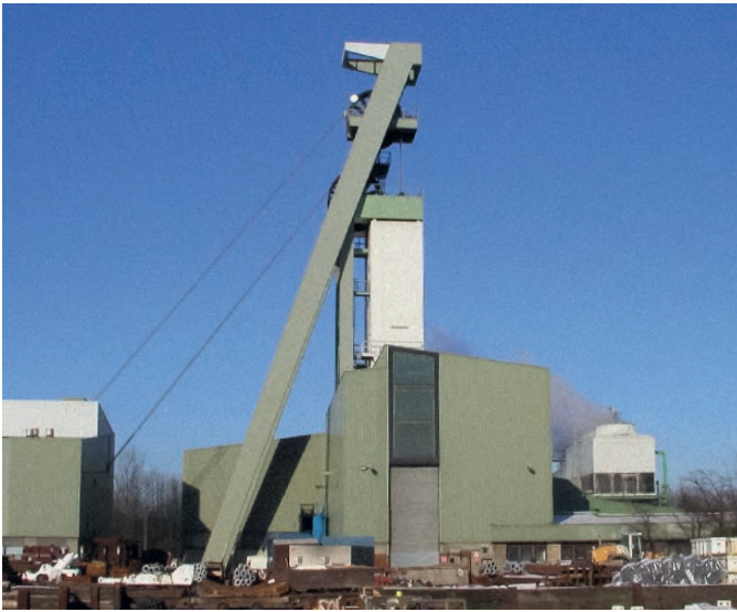
Fig. 5. Prosper V Shaft 10 // Bild 5. Prosper V Schacht 10. Source/Quelle: Redpath Deilmann
