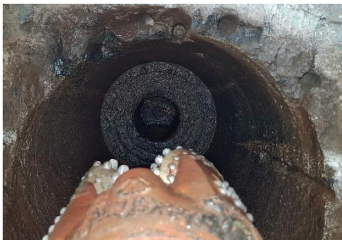
Fig. 5. Drill hole with tricone in the front. // Bild 5. Bohrloch mit Tricone im Vordergrund. Photo/Foto: Perforator
