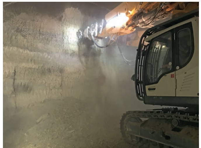
Fig. 1. Drivage with excavator cutting head. Bild 1. Vortrieb mit Baggerfräskopf. Photo/Foto: Korfmann
