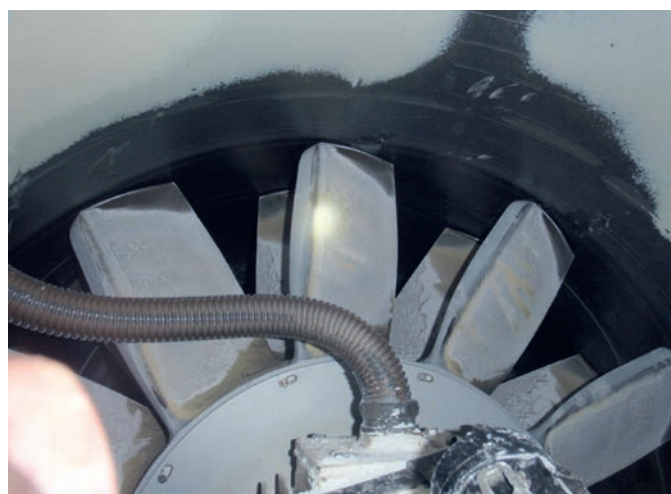
Fig. 9. Wear due to dust action. Bild 9. Verschleiß durch Staub. Photo/Foto: Korfmann
