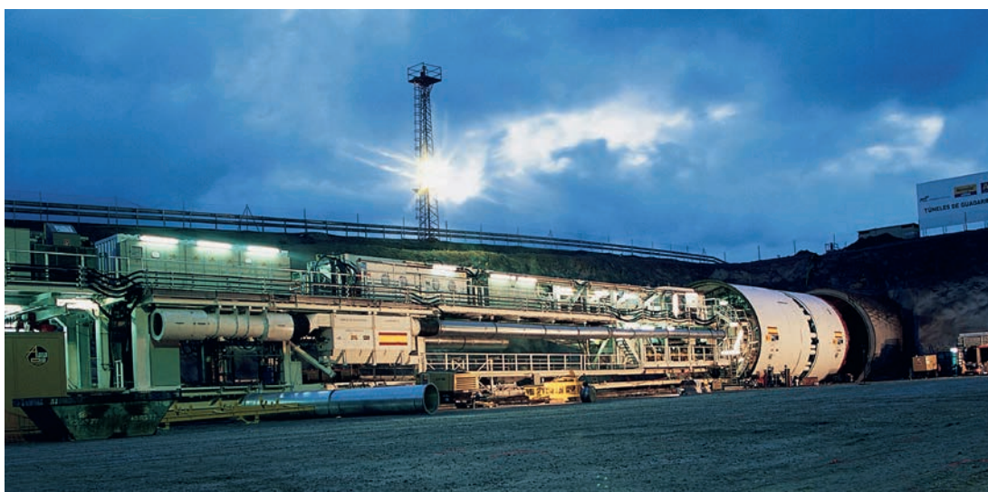
Fig. 3. Full-face cutting machine tunnelling. // Bild 3. Vollschnittmaschinenvortrieb. Photo/Foto: CFT
