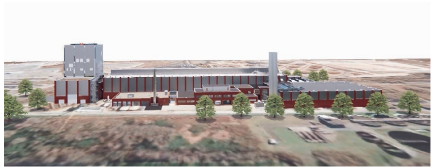
Fig. 6. Konrad 2 Shaft repository with surface facilities. // Bild 6. Endlager Schacht Konrad 2 mit Übertageanlagen. Source/Quelle: BGE
