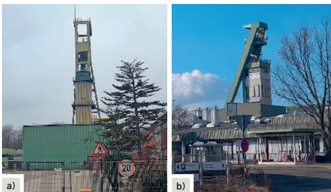
Fig. 3. Mine shafts 9 (a) and 10 (b) at Prosper-Haniel colliery. Bild 3. Schächte 9 (a) und 10 (b) des Bergwerks Prosper-Haniel. Photos/Fotos: M. Pawlik
