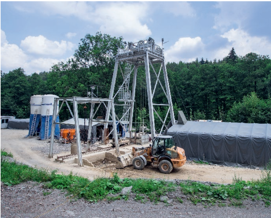
Fig. 2. Pöhla shaft construction site. // Bild 2. Schachtbaustelle Pöhla. Photo/Foto: SME
