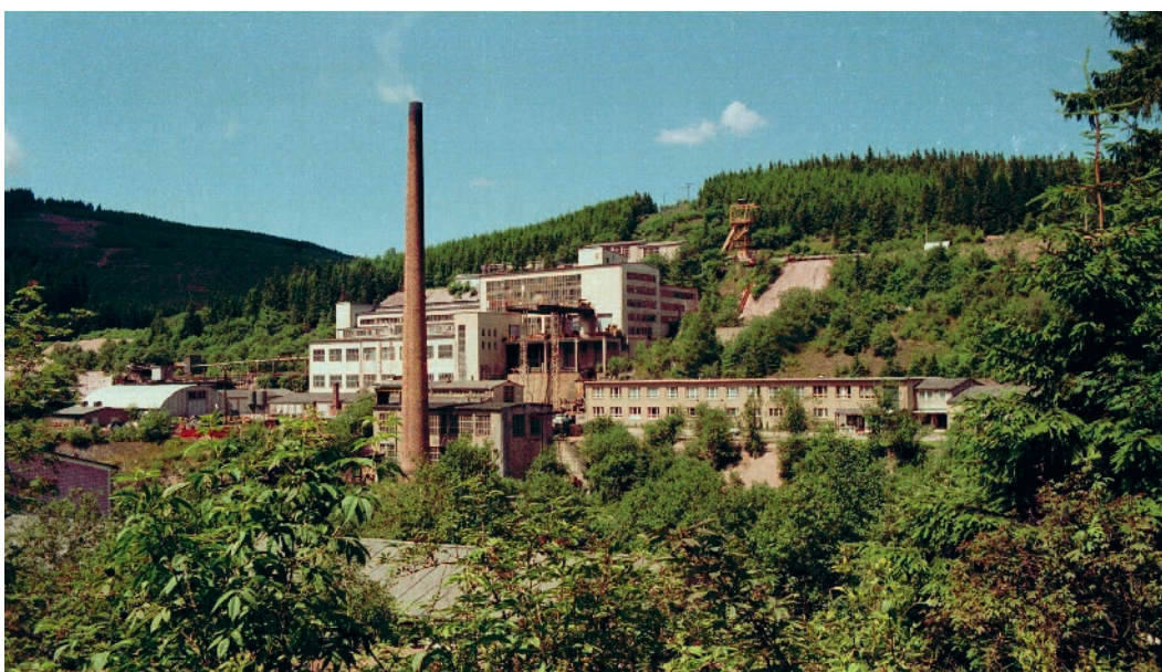
Fig. 1. Historic photo of the mine's surface facilities. Bild 1. Historische Aufnahme der Tagesanlagen der Grube. Photo/Foto: MDF
