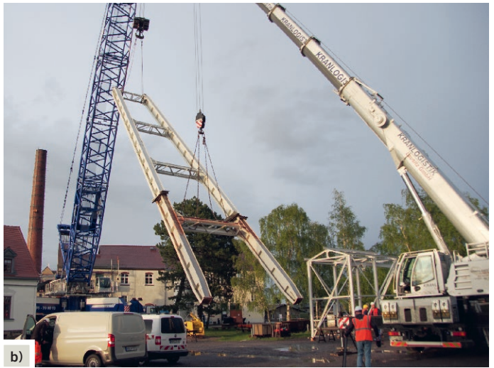
Bild 3. Herausheben von Führungsgestüt (a) und Schrägstrebe (b). Photos/Fotos: Kerstin Rysavy, SBN
