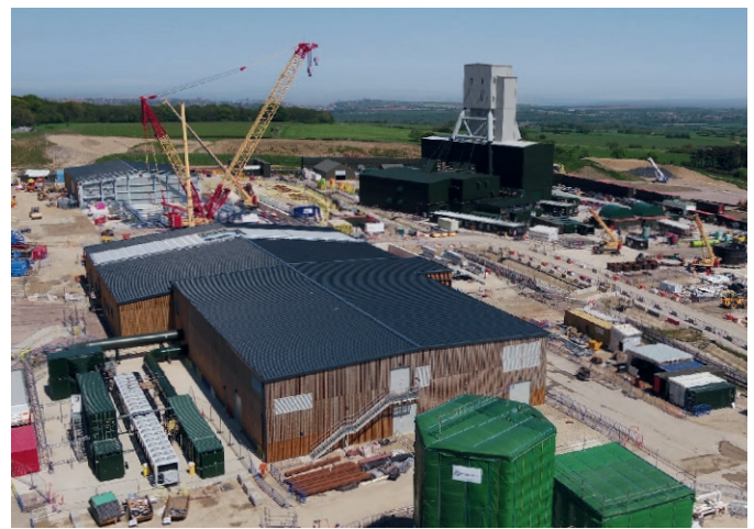
Fig. 3. General view of the construction site of Woodsmith mine with MTS shaft (back right), service and production shaft (one behind the other on the left). // Bild 3. Gesamtansicht der Baustelle des Bergwerks Woodsmith mit MTS-Schacht (hinten rechts), Service- und Produktions-schacht (links im Bild hintereinander). Photo/Foto: Redpath Deilmann
