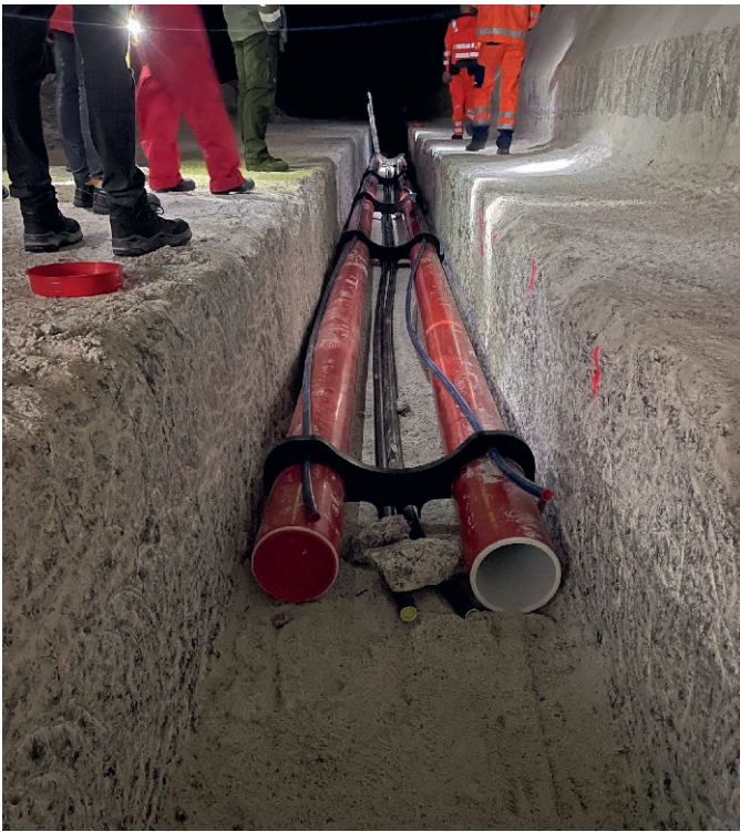
Fig. 5. Experimental cable trench. Bild 5. Probekabelgraben. Photo/Foto: SWS
