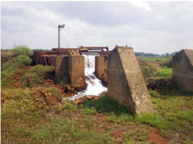
Fig. 1. Uncontrolled decanting AMD at a flooded shaft in the Western Basin (2011). // Bild 1. Saures Grubenwasser tritt unkontrolliert aus einem gefluteten Schacht im Western Basin aus (2011). Photo/Foto: Winde
