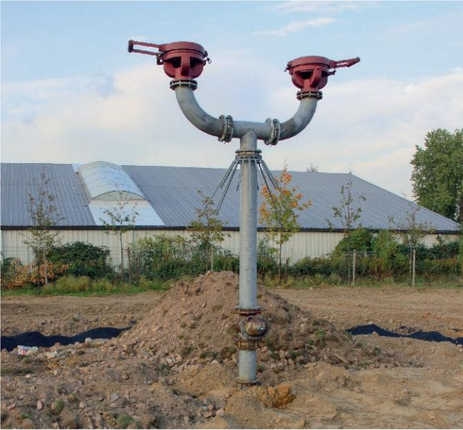
Fig. 4. Protego hood. // Bild 4. Protegohaube. Photo/Foto: Iqony
