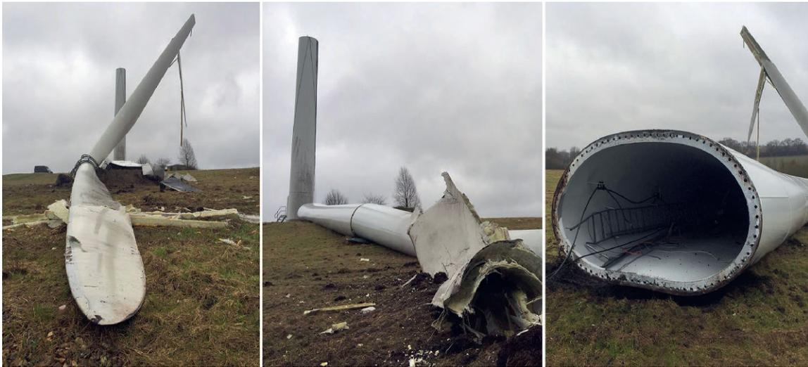
Fig. 6. Toppled wind turbine. // Bild 6. Umgestürzte Windturbine. Photos/Fotos: agrarheute.com 2017
