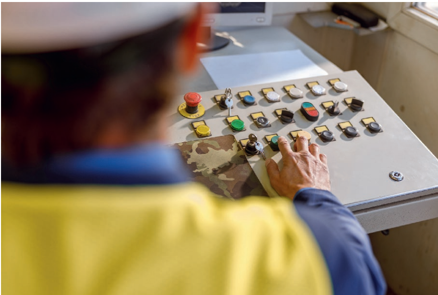
Fig. 2. After maintenance work has been completed, installations must be released for recommissioning. // Bild 2. Nach dem Abschluss von Instandhaltungsarbeiten müssen Anlagen zur Wiederinbetriebnahme freigegeben werden. Photo/Foto: © yaroslav astakhov, stock.adobe.com
