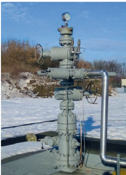
Fig. 9. CO 2 injection well of the research storage facility in Ketzin 2010. Bild 9. CO 2 -Injektionsbohrung des Forschungs-speichers in Ketzin 2010. Photo/Foto: BGR 2023
